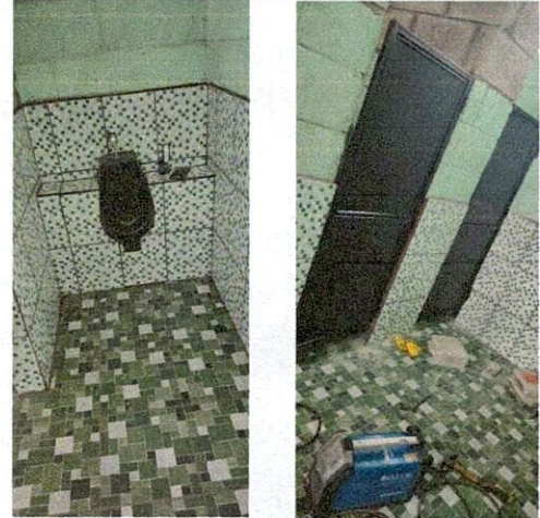
Foto 2: Avance y mejoramiento de servicios sanitarios y migitorios.
