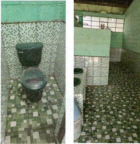
Foto1: Reparación de servicios sanitarios.
